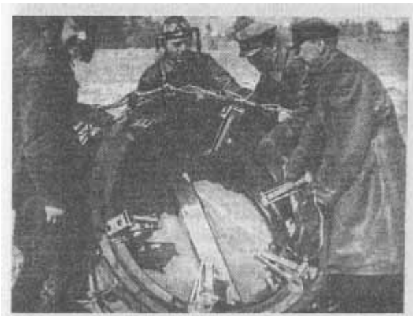
Клапан стравливания воздуха оболочки стратостата "СССР"
